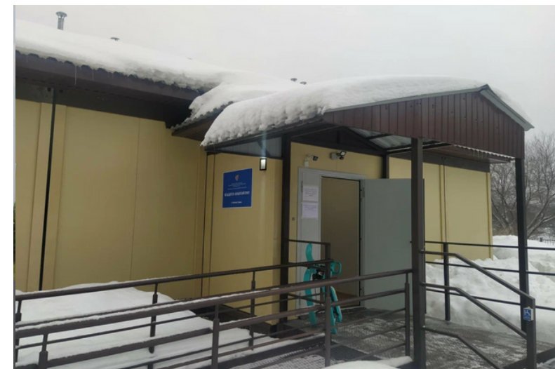
СТРОИТЕЛЬСТВО 35 ФЕЛЬДШЕРСКО- АКУШЕРСКИХ ПУНКТОВ
