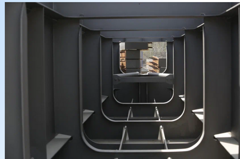
РЕМОНТ 13 МОСТОВ И ПУТЕПРОВОДОВ
