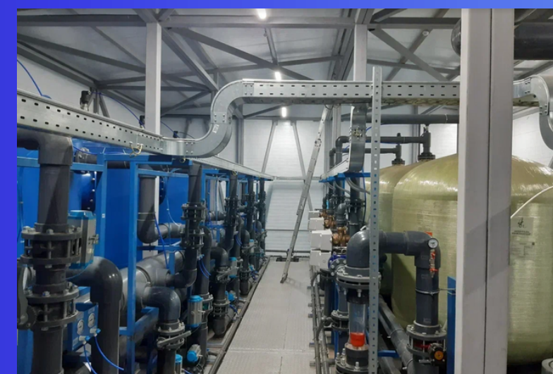
СТРОИТЕЛЬСТВО И РЕКОНСТРУКЦИЯ 7 ОБЪЕКТОВ ВОДОПОДГОТОВКИ
